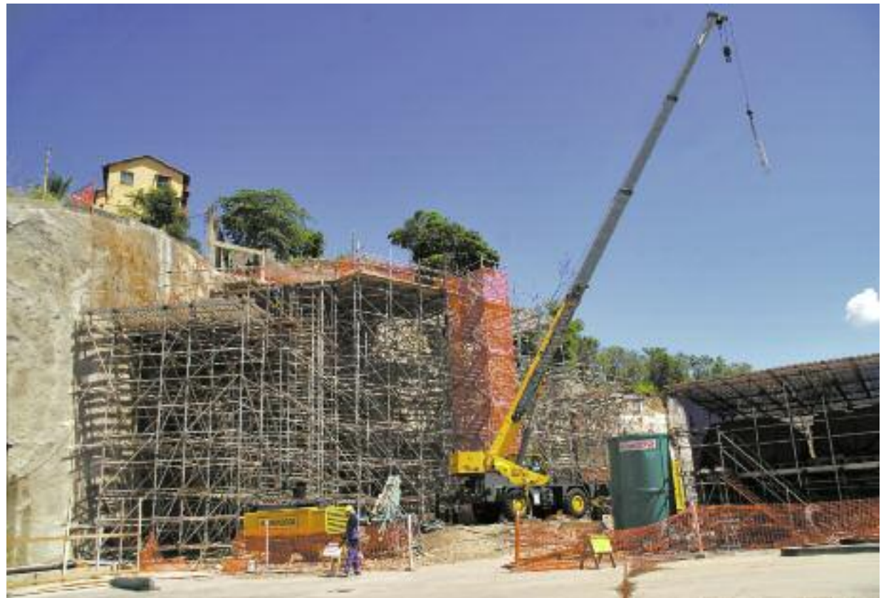
Obras do túnel da Saúde, parte das obras do Porto Maravilha
