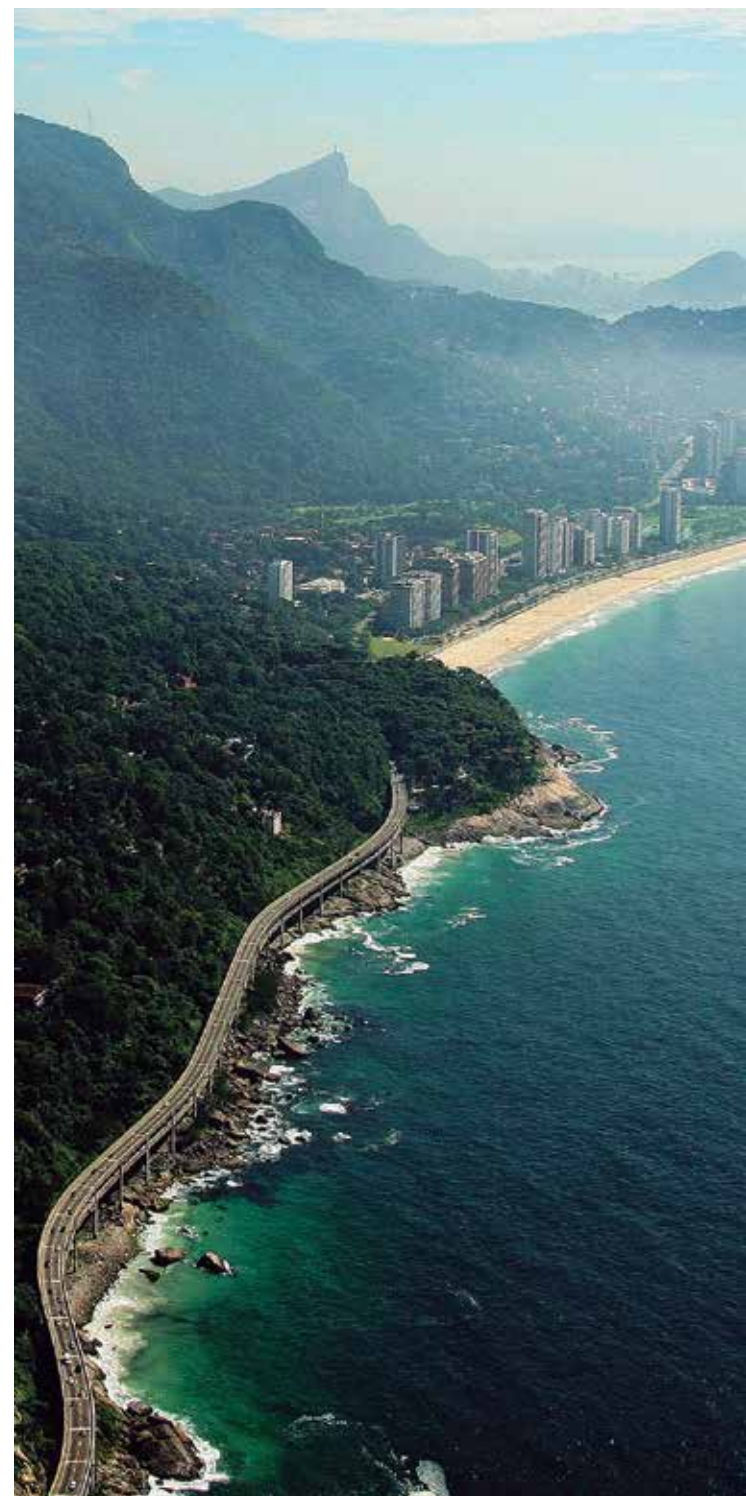
Uma das principais ligações da Barra com a Zona Sul, o viaduto do Joá apresenta visível degradação estrutural e, segundo técnicos, existe risco iminente de colapso.
