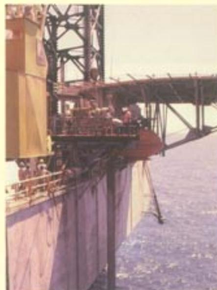
Figura 4 - Equipamento em balanço sobre jack-up com auxílio de tubo-guia cravado no fundo do mar
