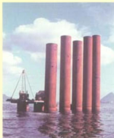
Figura 3 - Sondagem com equipamento sobre monotubo
